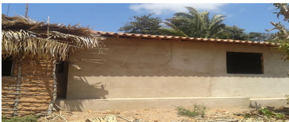
Foto 03: casa camponesa com estrutura física precária ao lado de unidade do PNHR, em construção:
