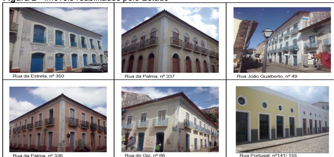
Figura 2 - Imóveis reabilitados pelo Estado
