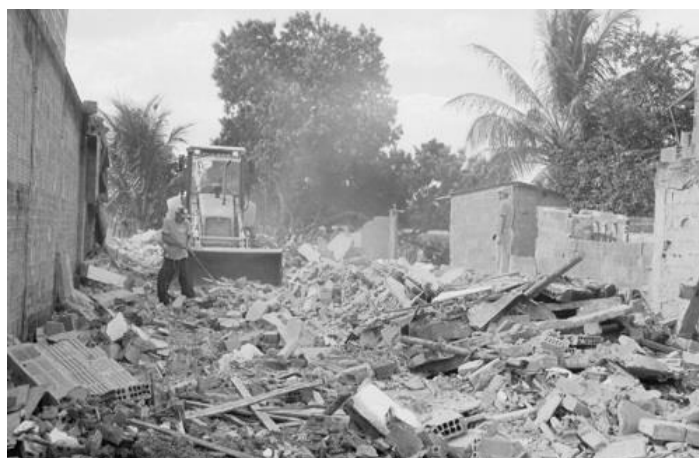
Figura 1: Demolição das antigas casas ocupadas em áreas de risco no bairro Parque Prazeres, Campos dos Goytacazes (RJ)
